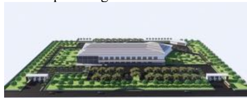
Gambar 19. Area depan bangunan
