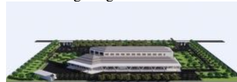
Gambar 21. Area Belakang bangunan
